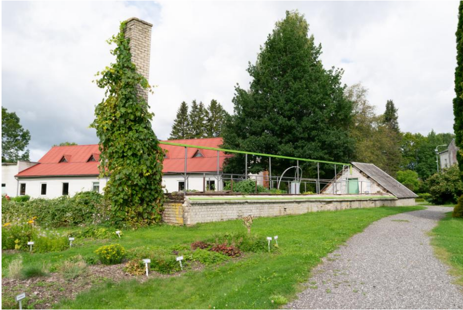
Joonis 1. Kasvuhoone renoveerimine 23.08.2024 (Arumäe, 2024)
